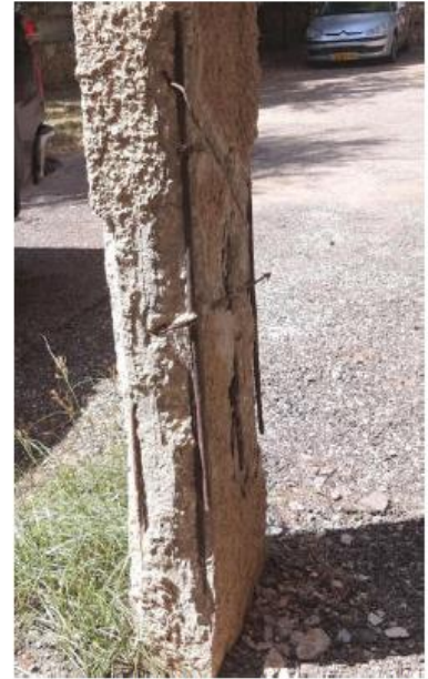
עמוד במצב חמור ובו חשיפה של מוטות הזיון, הקטנת חתכם וחתכי החישוקים
